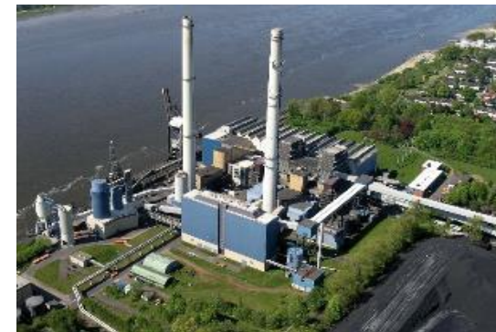
Wedel CHP-laitos, Saksa
