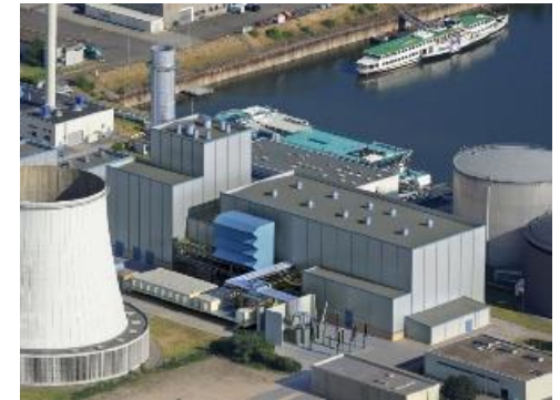
Köln-Niehl hybridi lämmön – ja sähkön tuotantolaitos (CHP), Saksa
